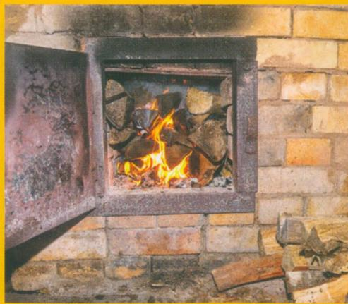
*Печи должны иметь установленные нормами противопожарные разделки (отступки) от горючих конструкций, а также предтопочный лист размером 0,5х0,7 м, без прогаров и повреждений.*
